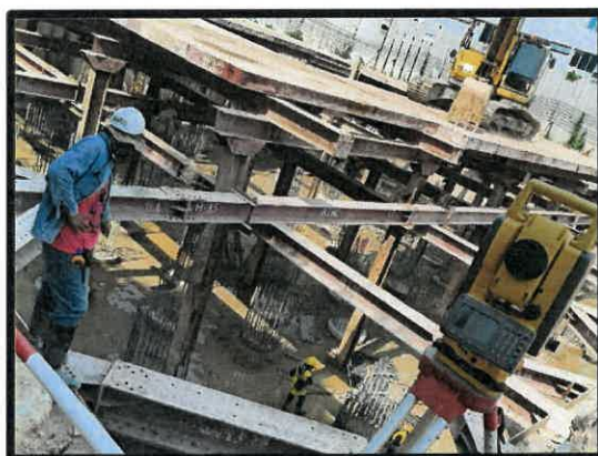
รูปที่ 3-37 การตั้งกล้องเพื่อตรวจสอบค่าระดับ
