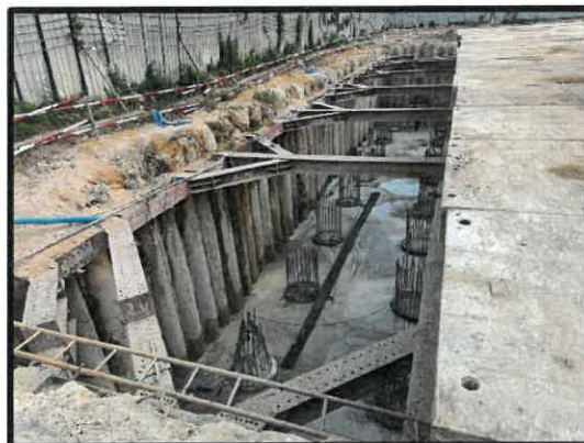
รูปที่ 3-8 ระบบป้องกันดินพังของโครงการ
